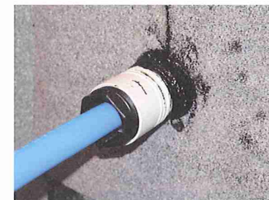
Przejście przewodu wodociągowego z SE-MD 20/50
